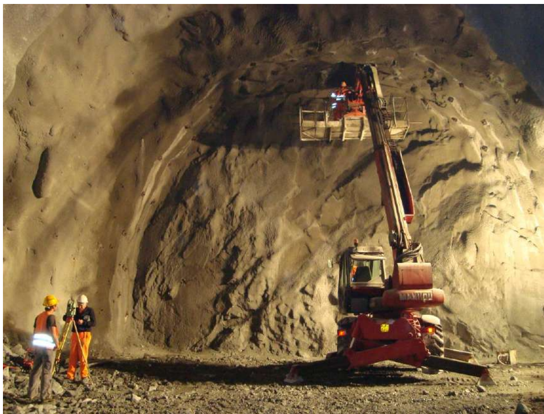
Verifiche di scavo e controllo fronte galleria Mules - Tunnel di Base del Brennero - BBT
