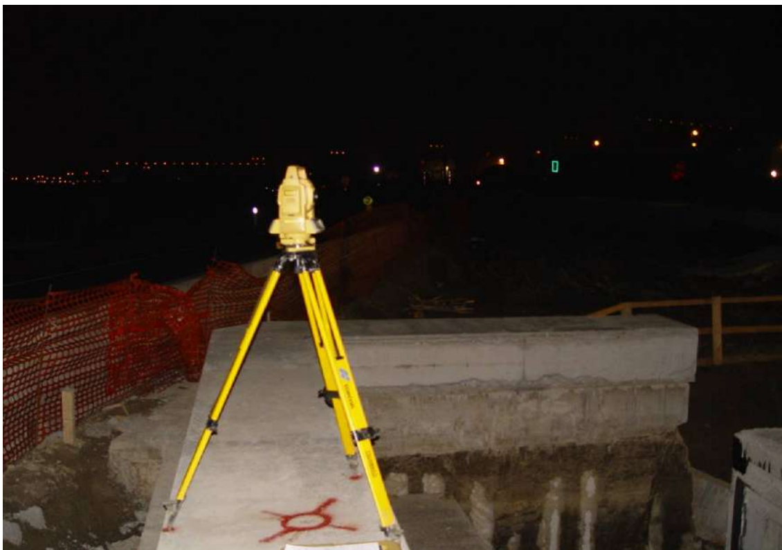
Collaudo travi gemelle ferroviarie (lav. In notturna)
