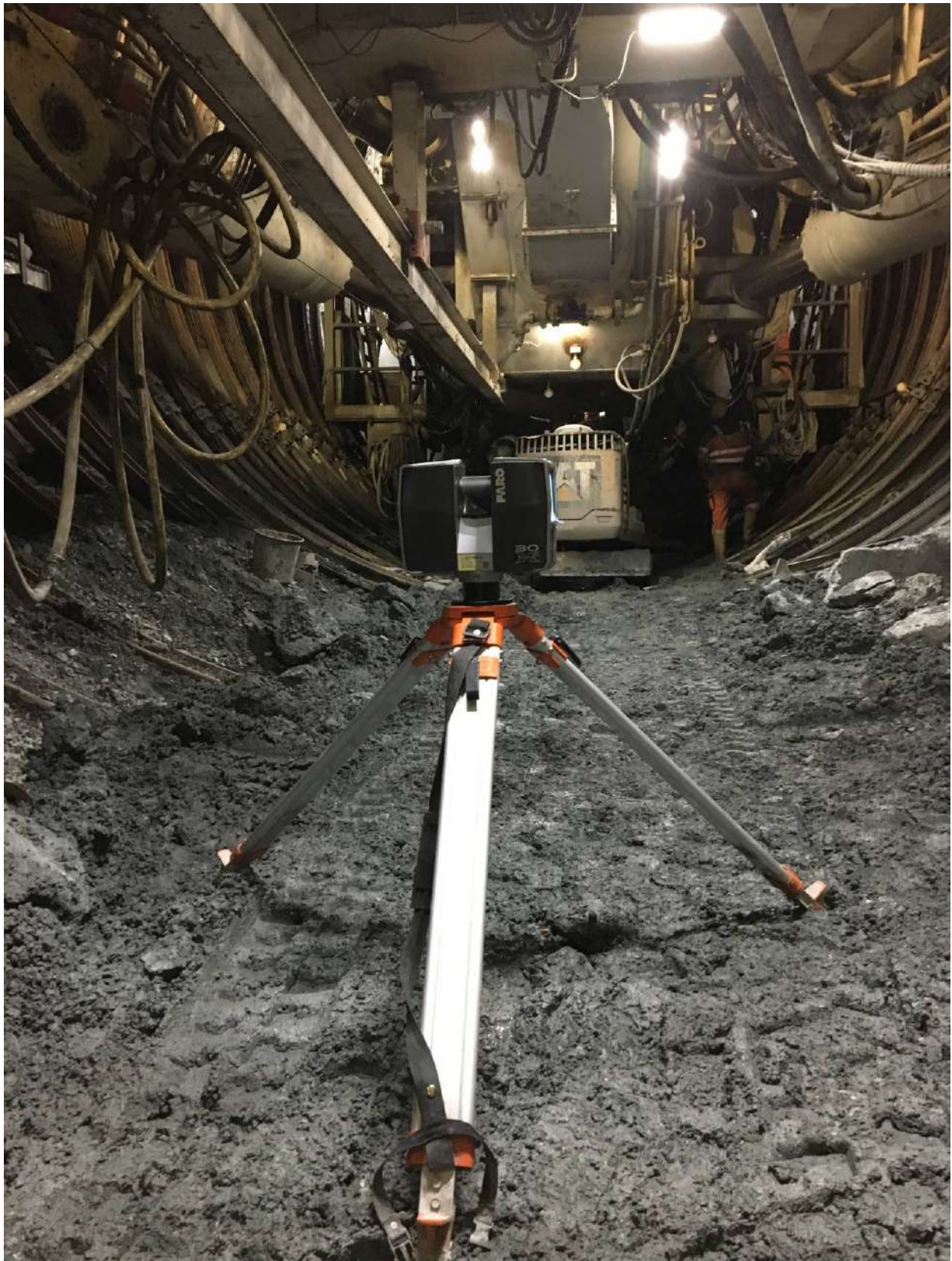
Scansioni Laser per verifiche e controllo di scavo TBM
