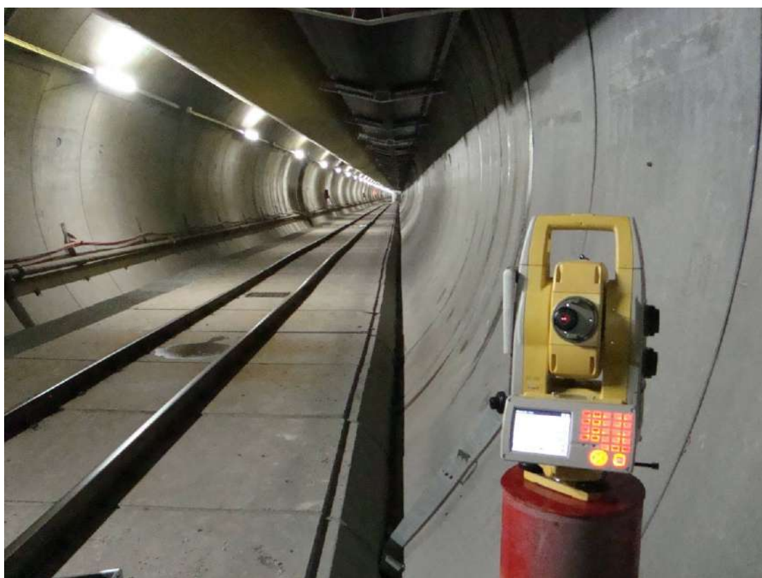
Controllo poligonale interna cunicolo esplorativo Aica - Tunnel di Base del Brennero - BBT
