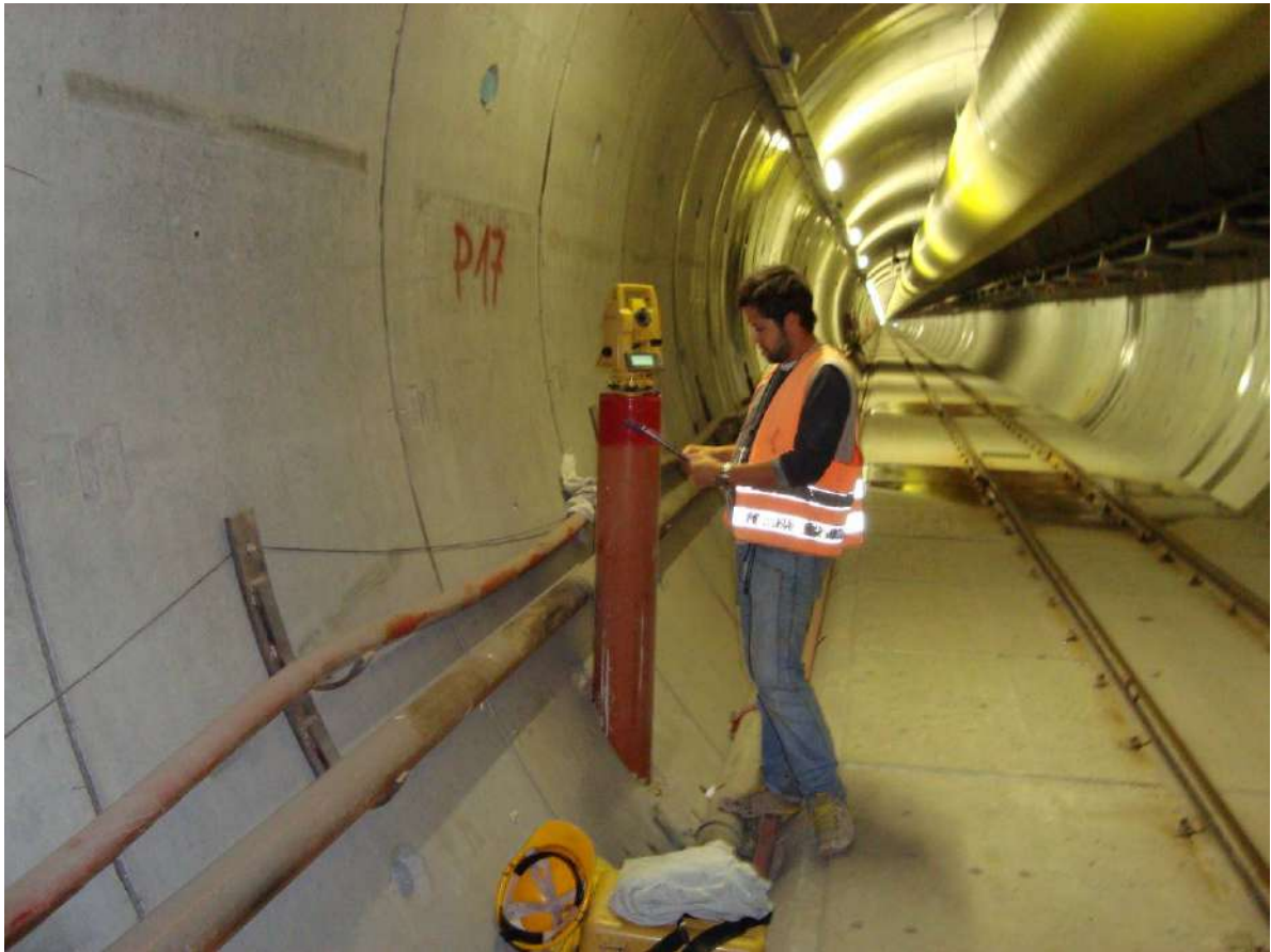
Controllo tracciato d'asse Tunnel di Base del Brennero - BBT
