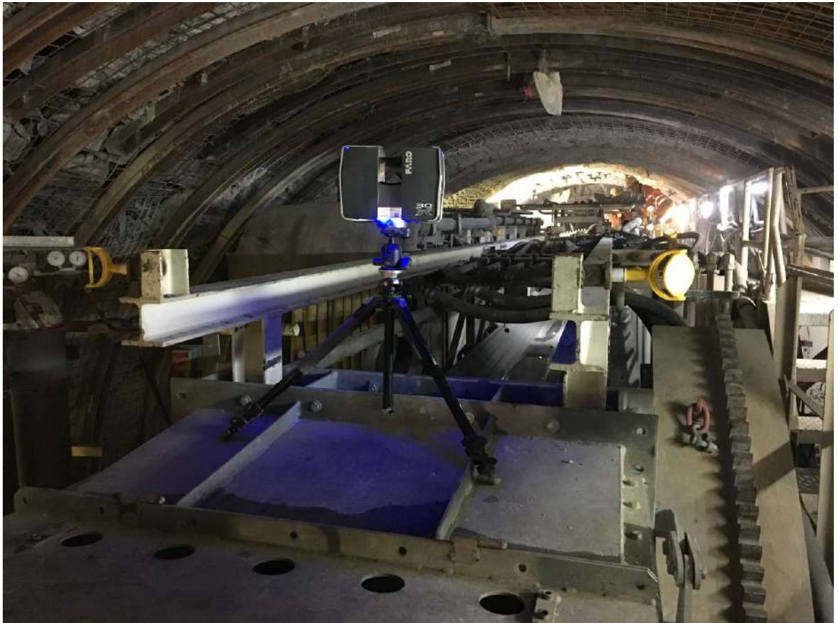
Scansioni Laser per verifica profili di sotto_scavo
