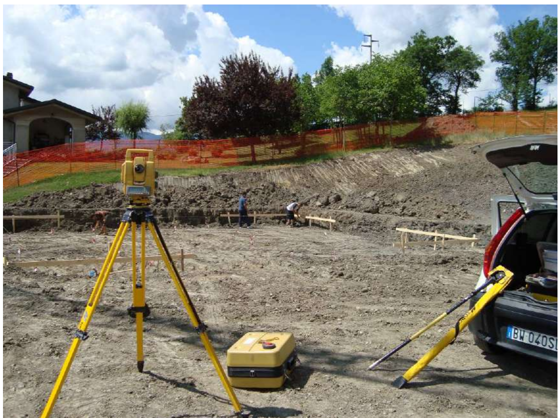
Figura: Tracciamento esecutivo di modine e quote in cantiere
