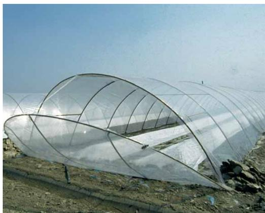
*Il film LONG LIFE è un film di polietilene altamente stabilizzato ai raggi UV. Il master additivo impiegato è simile a quello del film additivato e del film superadditivato, ma in una concentrazione decisamente superiore. E' proposto nello spessore di 200 microns e consigliato per la copertura di serre e tunnels per le coltivazioni pluriennali (fino a tre campagne agricole).*
